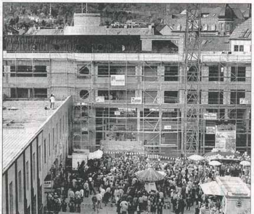
Kurz vor dem Start: So sah es beim Richtfest im Herbst 1990 am Bahnhof Wilhelmshöhe aus. Ein Jahr später eröffnete das City Center.
